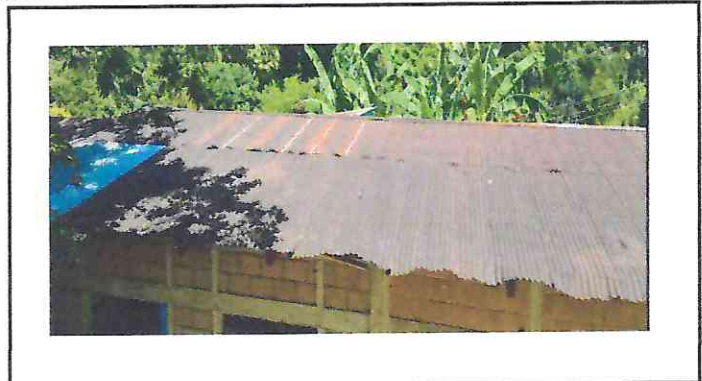
Foto 2: Sustitución de lamina canalada por lamina troquelada
