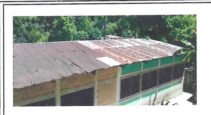
Foto 1: Sustitución de lamina canalada por lamina troquelada
